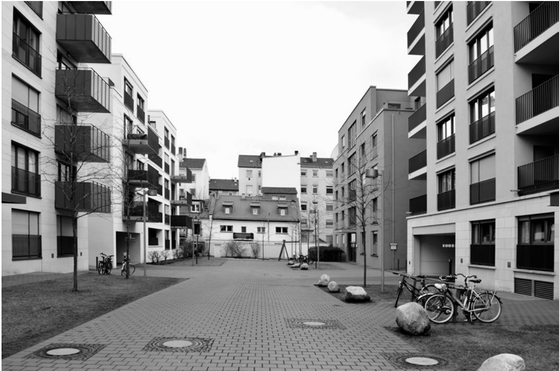
Europaviertel, Frankfurt am Main, 2016
