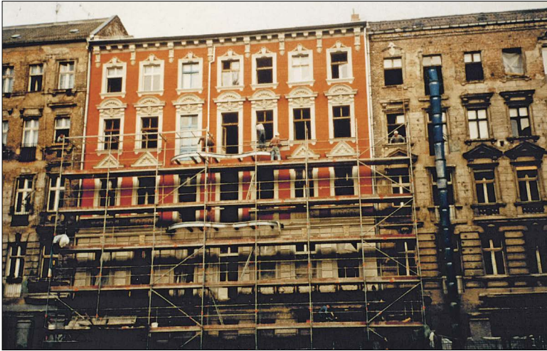
Rykestraße 14, mit eingerüsteter Fassade, November 1994 © M. Schroedter
