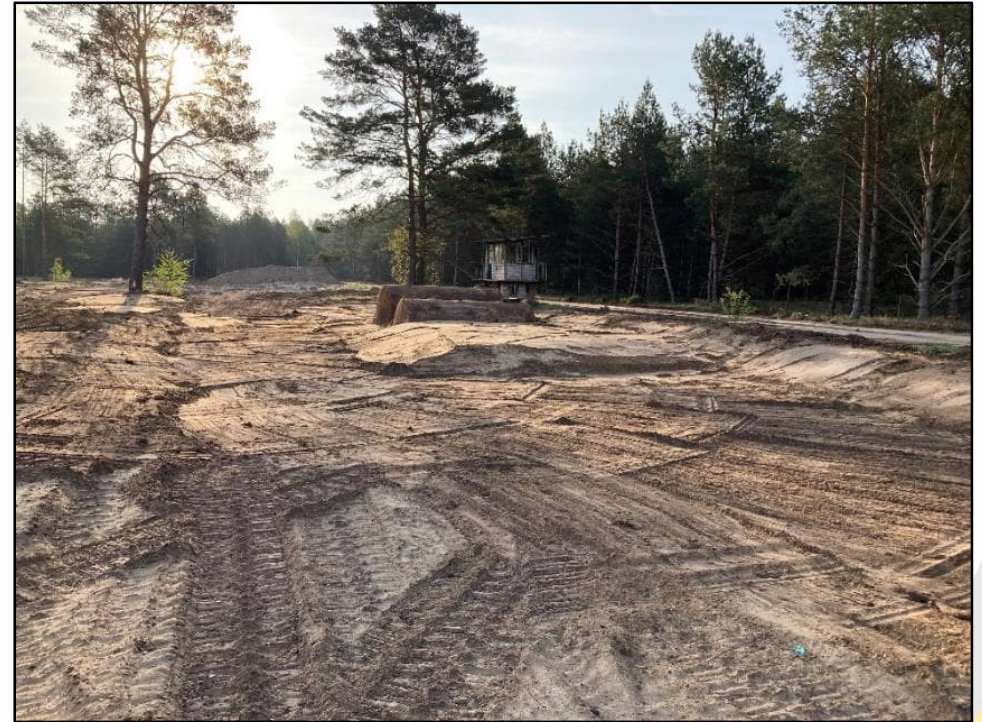
Verbleibende Tanks (Denkmalschutz)
