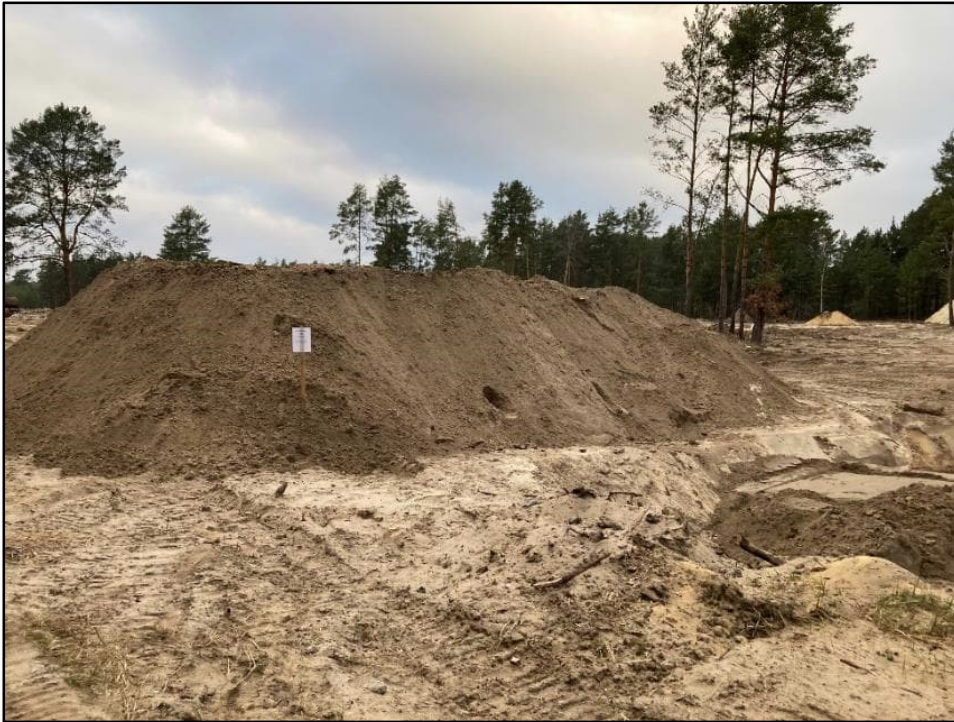
Bodenhauwerk zur Entsorgung
