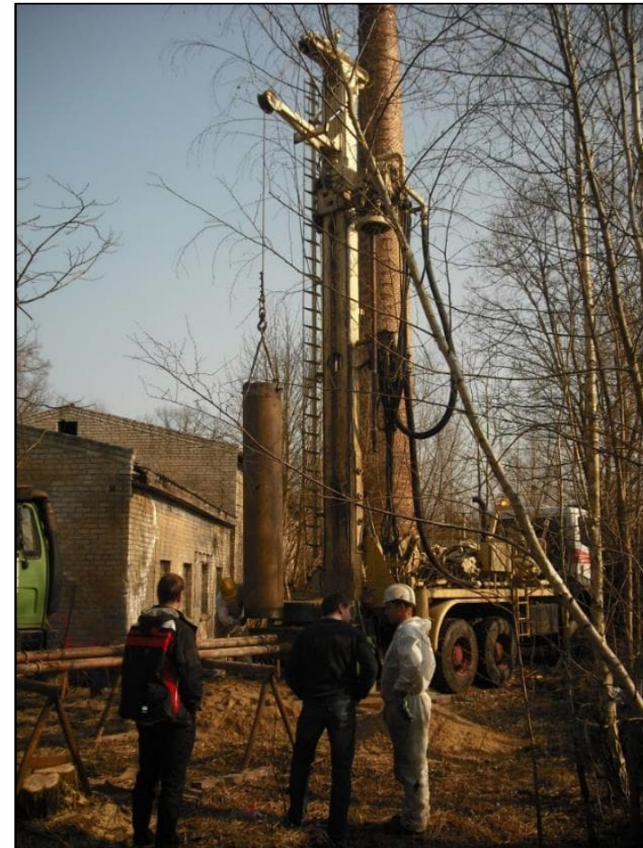
Errichtung neuer tiefer Sanierungsbrunnen 2011
