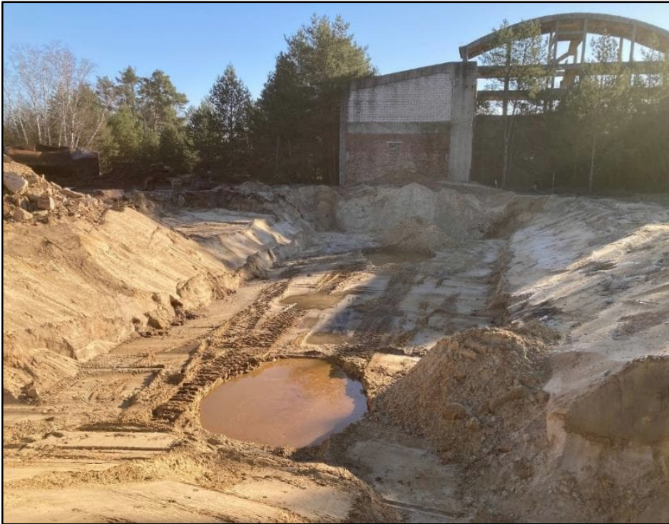
Tankbett nach Bergung der Tanks und Leitungen März 2025 mit Schürfen (Grundwasseranschnitt)
