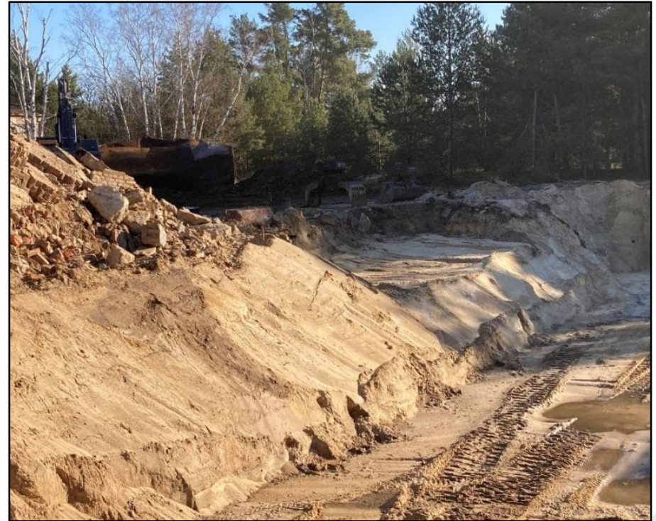
Tankbett nach Bergung der Tanks und Leitungen März 2025 mit Schürfen (Grundwasseranschnitt)
