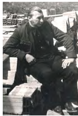
Egon Hartmann auf dem Bauplatz des Regierungsbauhauses in Berlin, 1950
