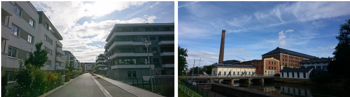
Abbildung 3: Wohnbebauung und industrielles Erbe auf dem ERBA-Gelände
