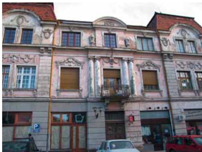
Unterschiedliche Entwicklungskontexte sind der Hintergrund für einen differenzierten Revitalisierungsstand. Im historischen Zentrum Oradeas (Rumänien) gibt es einen reichen Bestand noch unsanierter Jugendstilgebäude.
