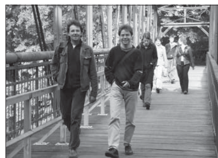
Die Fußgängerbrücke über das Flakenfließ führt vom S-Bahnhof Erkner zum IRS.
