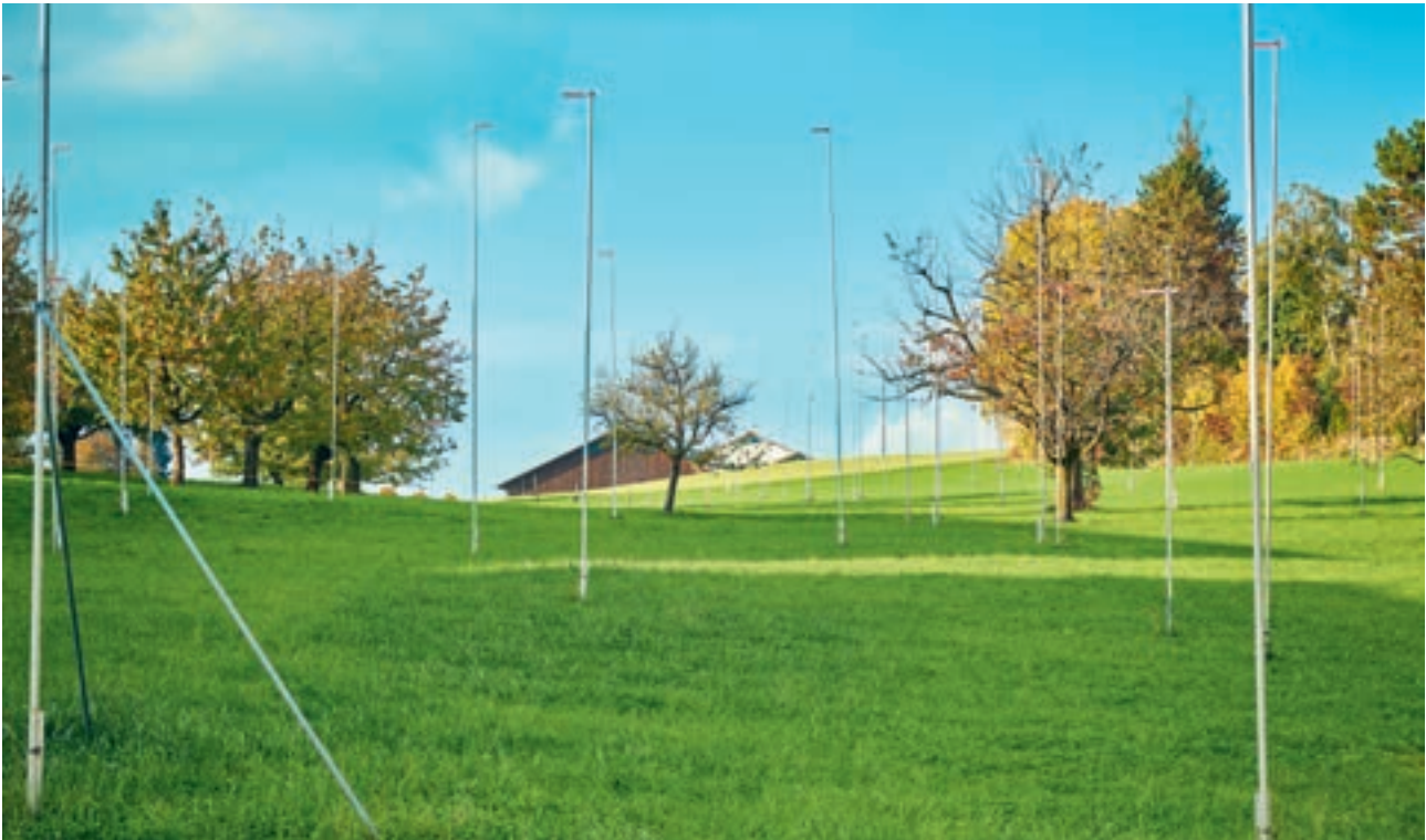
Ein Baugespann. In der Schweiz werden mit Hilfe von Stangen die Ausmaße – Grundriss und Höhe – von geplanten Gebäuden markiert. Potenzielle Raumnutzungskonflikte werden so für die Allgemeinheit sichtbar. Konflikte zeigen sich oft in konkreten Konflikträumen (etwa anhand eines lokalen Bauprojekts), hängen aber zugleich mit größeren Raumkonflikten zusammen, die sich auch auf anderen Skalen abspielen.
