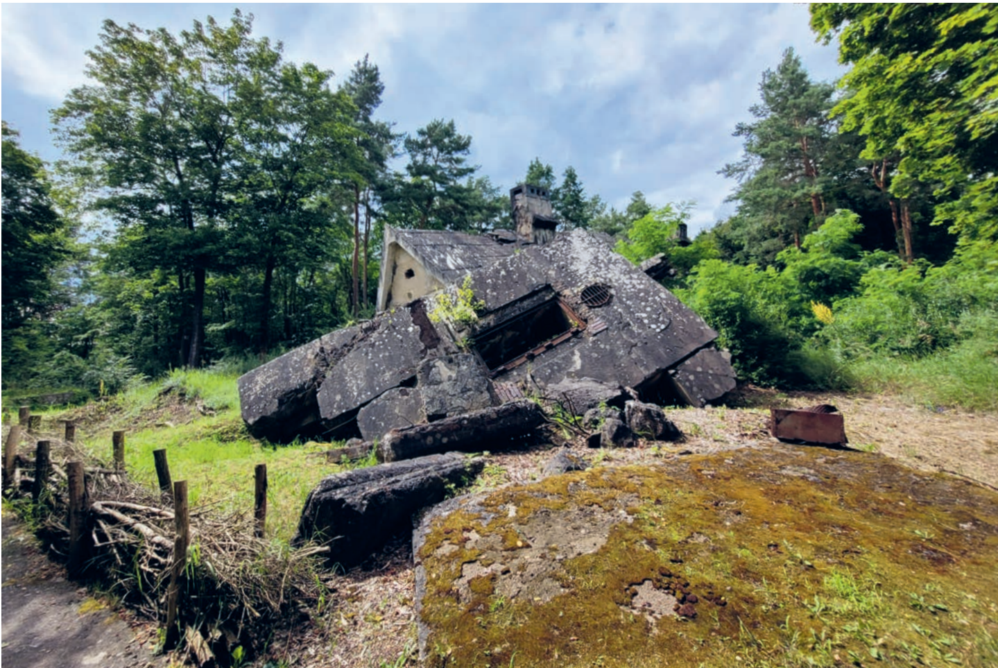
Von den Sowjets gesprengte Bunker bei Wünsdorf.
