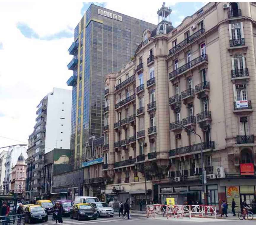
Die Avenida Callao mit einem Querschnitt durch die Baugeschichte
