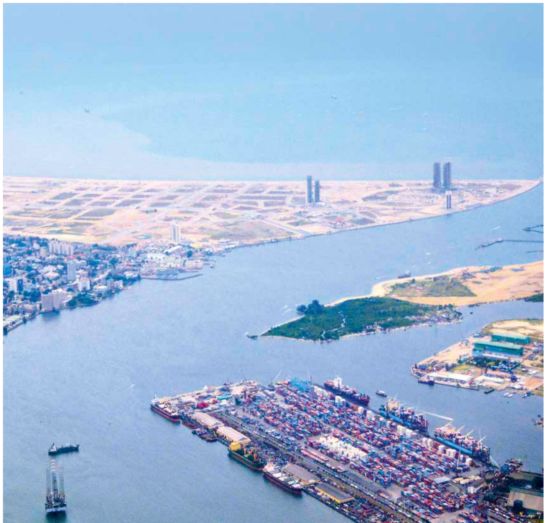
Lagos und seine Lagune mit Blick auf das Bauprojekt Eko Atlantic (Nigeria)
