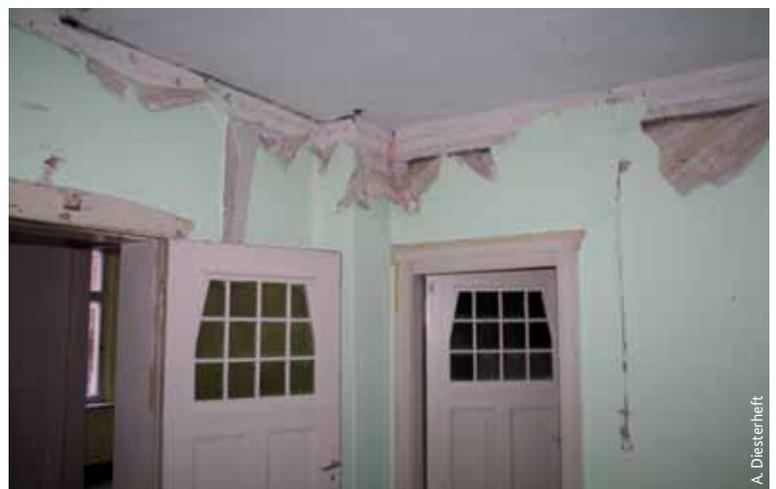
Das Architekturbüro Anke Diesterheft aus Malchin erstellte ein Modernisierungsgutachten zum Sanierungsbedarf: An den Fassaden des Gebäudes gab es Feuchtigkeitsschäden (links); im Innern blätterten Tapeten und Farbe von den Wänden (rechts).
