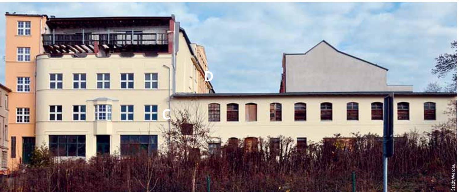
Die Sicherungsarbeiten am Versorgungsgebäude (Bauteil C) umfassten das Neuverputzen der Fassade.
